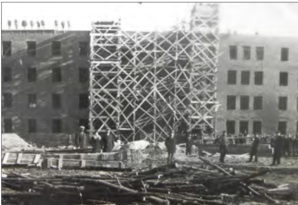
Zdjęcie 32. Budowa koszar dla II dywizjonu 4. pac w Tomaszowie Maz. – wiosna 1935 r.
