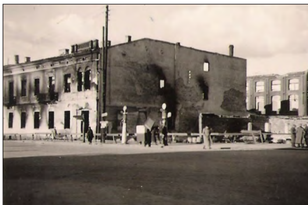
Zdjęcie 65. Zniszczone po bombardowaniu domy w centrum Tomaszowa Maz. (po wojnie w tym miejscu postawiono Dom Handlowy Niedźwiedź) – wrzesień 1939 r.
