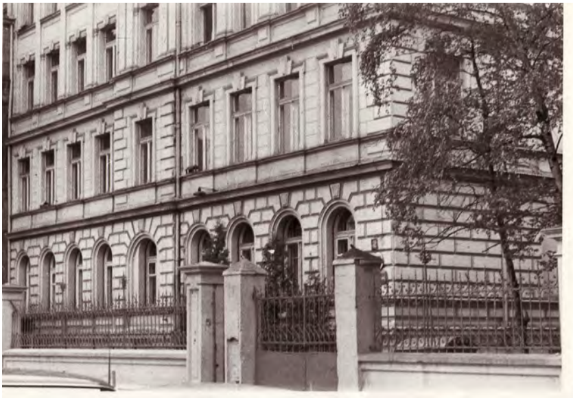
Budynek przedwojennego Gimnazjum im. Stefana Żeromskiego przy ul. Ewangelickiej (dzisiaj: ul. Franklina Delano Roosevelta 11/13) w latach 30.
