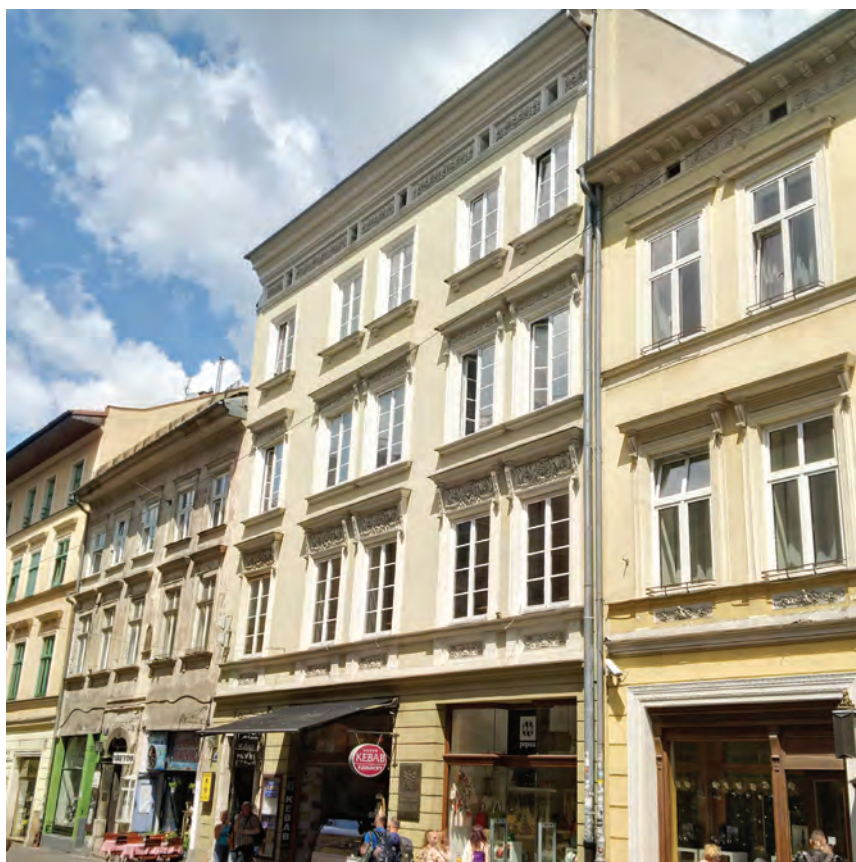
Fot. 2. Kraków, Kamienica przy ul. Szewskiej 21. Całe trzecie piętro zajmowało mieszkanie Piotra Stachewicza z pracownią malarską od podwórza. Na drugim piętrze, po prawej, dwa okna dawnego pokoju Melchiora Wańkowicza, później mieszkania Ewy Siedleckiej, jeszcze później – autorów artykułu, fot. R. Godula-Węclawowicz, 2023 r.
