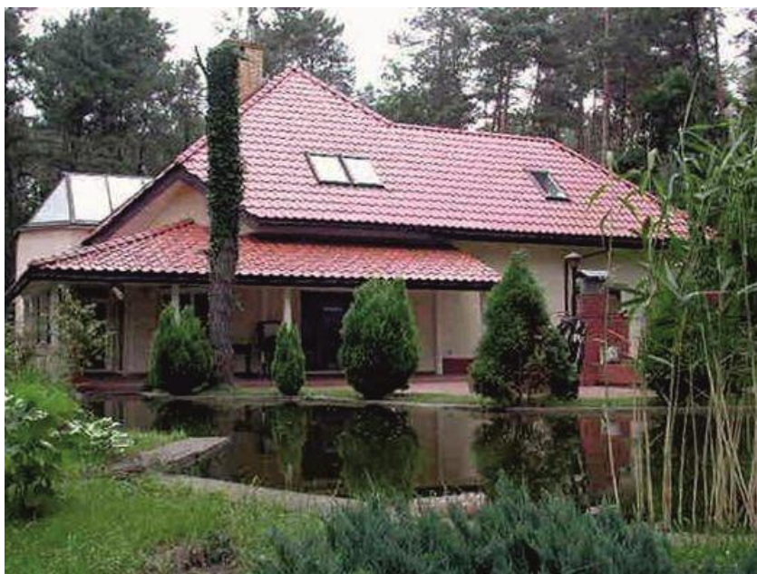
Fot. 5.1. Nieregularne kształty dachu budynków
