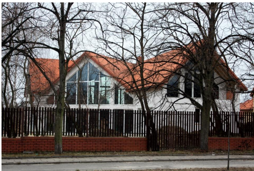
Fot. 5.5. Duże przeszklenia w bryle budynku rezydencji fot. L. Groeger
