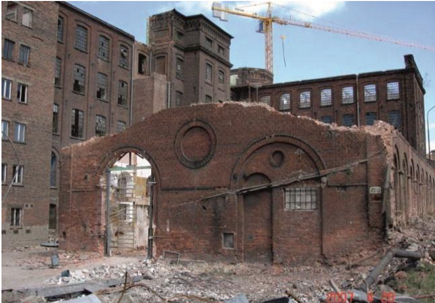
Fot. 3.2. Wyburzenia na osiedlu loftów „U Scheiblera” (24.04.2007)
