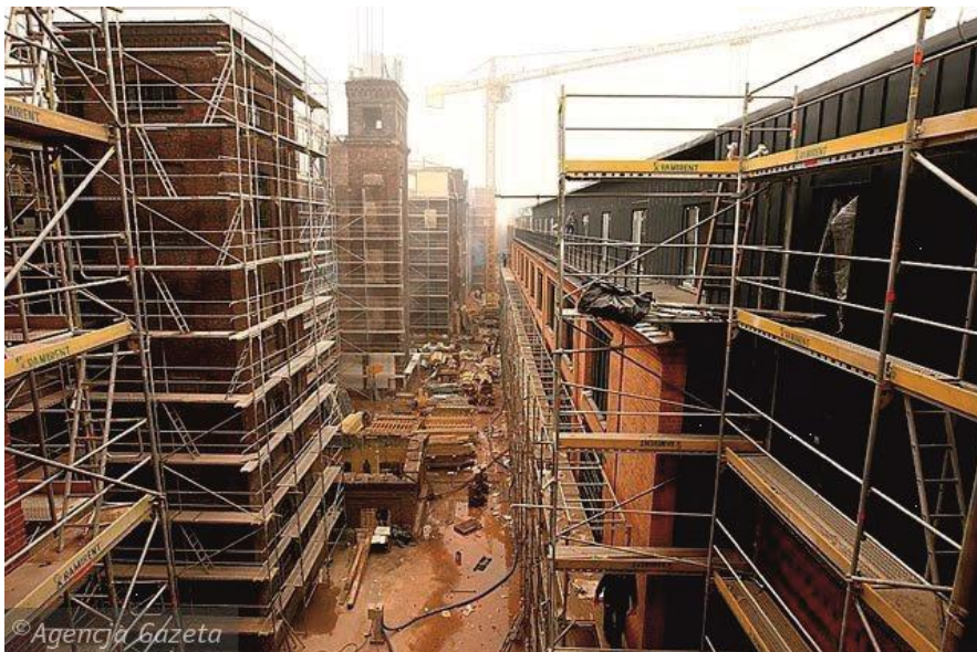
Fot. 3.3. Prace budowlane na osiedlu loftów „U Scheiblera”
