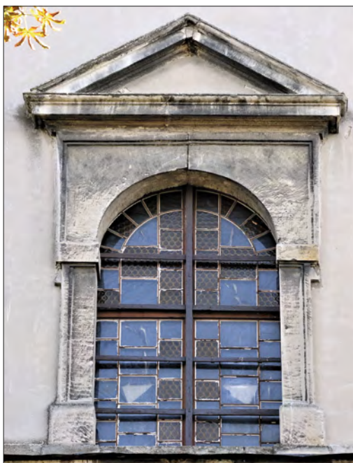
117. Koniecpol, kościół parafialny, fasada, okno drugiej kondygnacji. Fot. P. Gryglewski.
