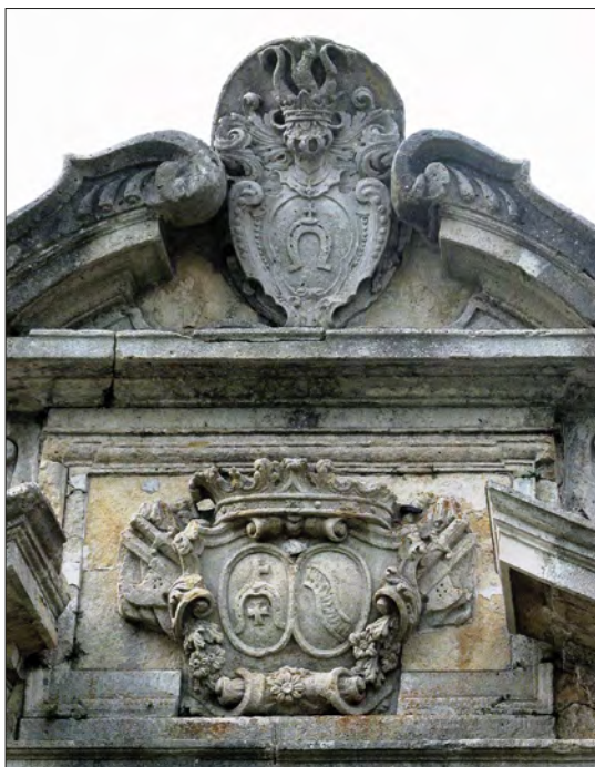
61. Podhorce, pałac, skrzydło frontowe, portal główny, zwieńczenie. Fot. K. Węglicka.
