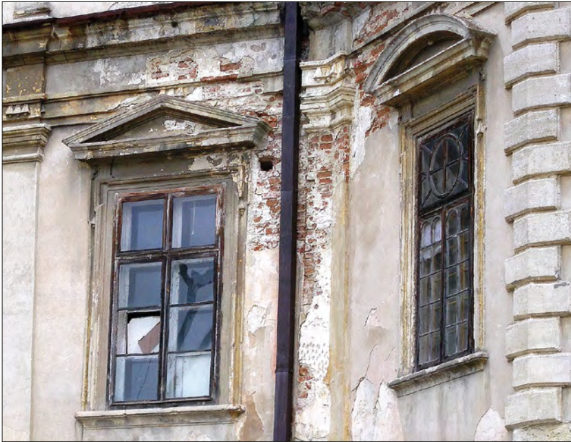
99. Podhorce, pałac, detal elewacji frontowej. Fot. K. Węglicka.
