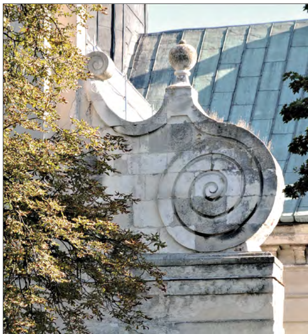
118. Konecpol, kościół parafialny, fasada, spływ wolutowy drugiej kondygnacji. Fot. P. Gryglewski.
