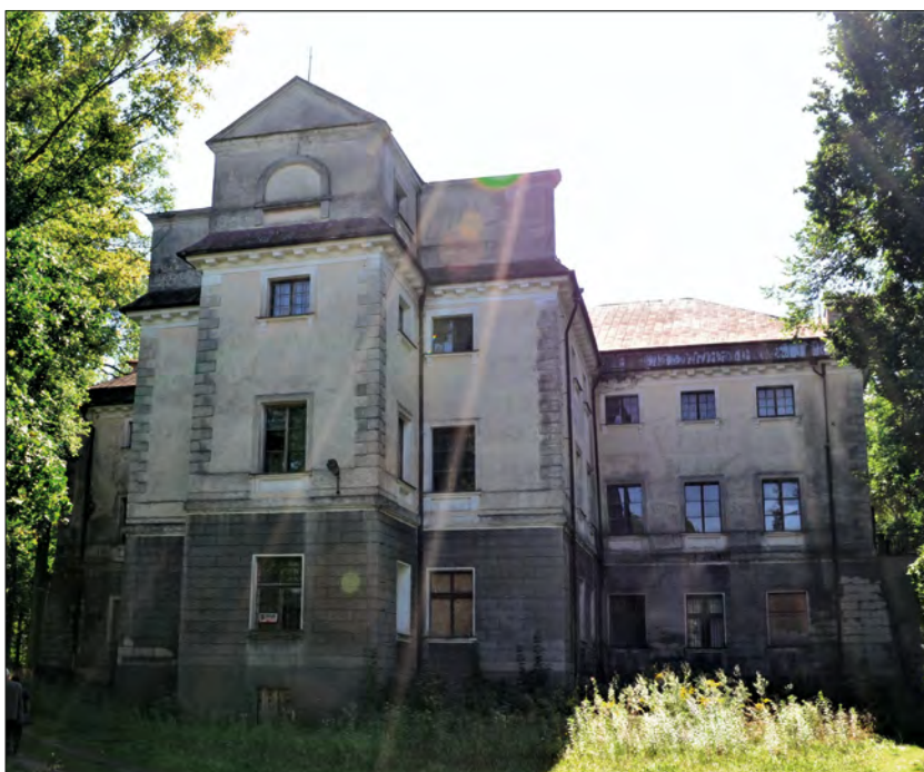
29. Chrzęstów-Konieczpol, pałac elewacja ogrodowa. Fot. P. Gryglewski.
