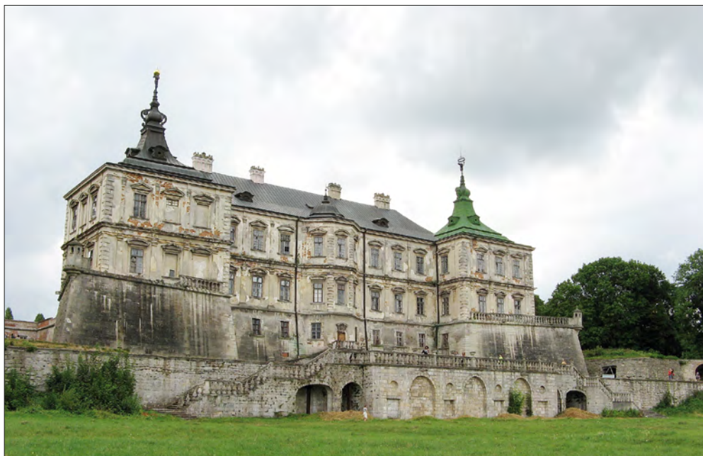
91. Podhorce, pałac, skrzydło frontowe, elewacja północna, od strony ogrodu. Fot. K. Węglicka.
