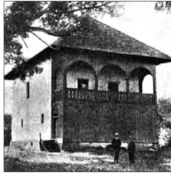
33. Rusiec, dwór, widok (fot. „Ziemia” 1910, nr 36, il. na s.566).
