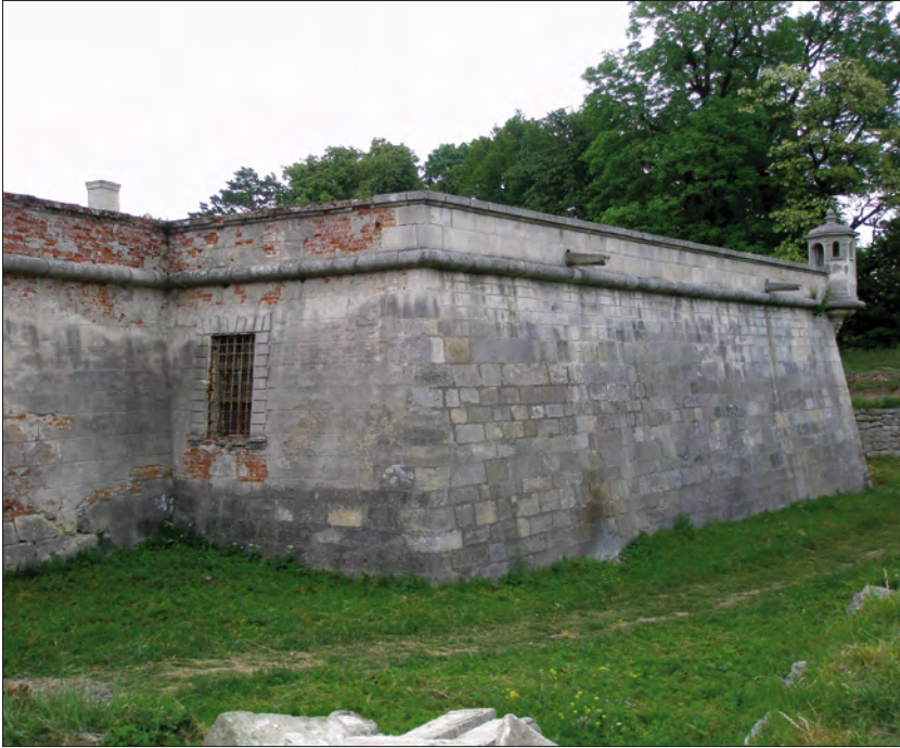
63. Podhorce, pałac, fortyfikacje, widok na bastion południowo-wschodni. Fot. K. Węglicka.
