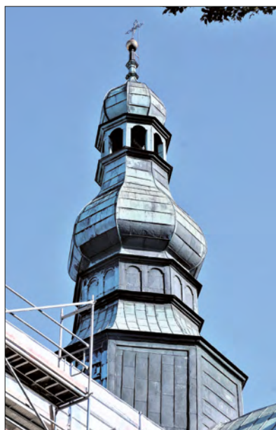
120. Konecpol, kościół parafialny, sygnaturka skrzyżowania naw. Fot. P. Gryglewski.
