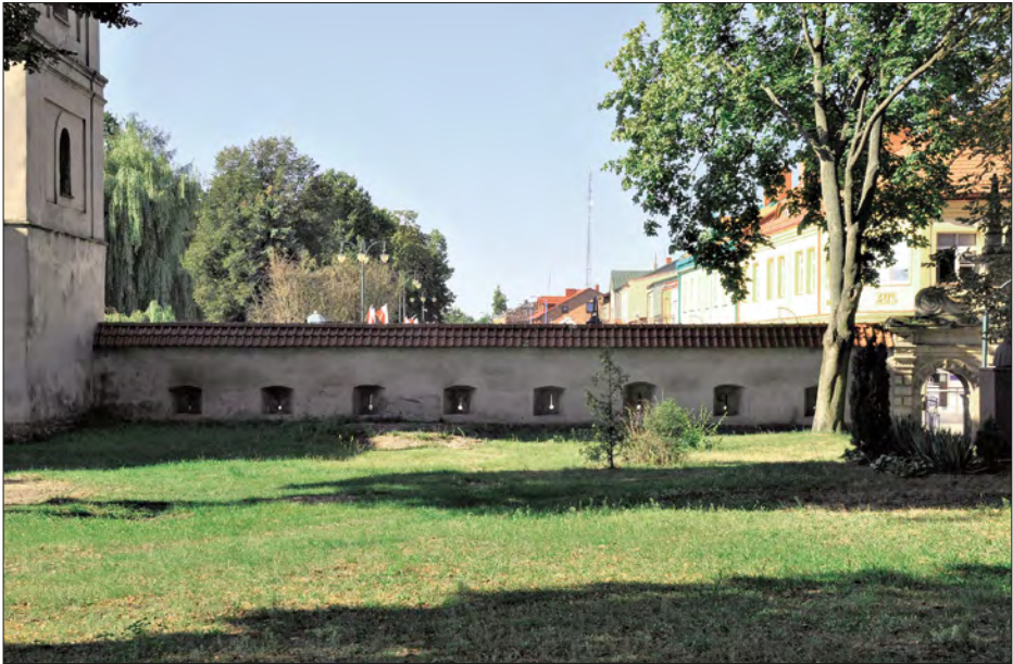
112. Koniecpol, kościół parafialny, mur ogrodzenia, widok od strony placu kościelnego. Fot. P. Gryglewski.
