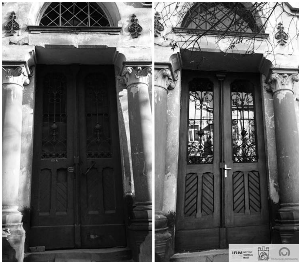
Fotografia 3.3. Brama w „domu Shulzów” na ul. Chmielnickiego, przed i po restauracji Źródło: dokumentacja projektowa.
