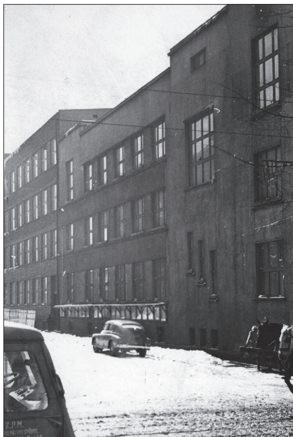
Fot. 2. Gmach wybudowany w 1929 r. dla pracowników biurowych wodociągów i kanalizacji w Łodzi przy ul. Narutowicza 65. Od 1946 r. – Rektorat UŁ. Ze zbiorów Archiwum UŁ
