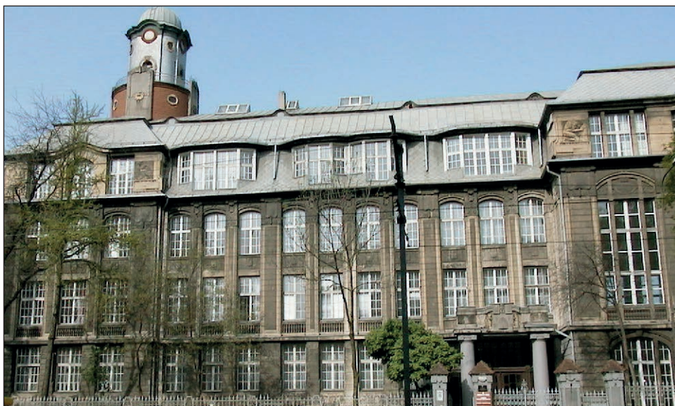
Fot. 14. Gmach Wydziału Filologicznego w budynku dawnego Gimnazjum Niemieckiego przy al. Kościuszki 65. Ze zbiorów Archiwum UŁ
