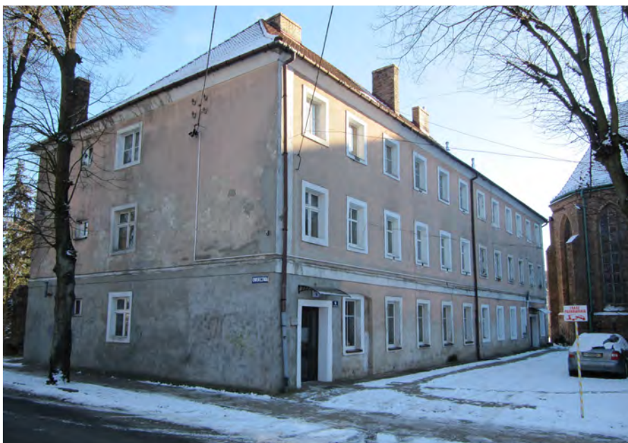
Ryc. 2. Zachowany budynek koszar – stan obecny (fot. Michał Gierke)
