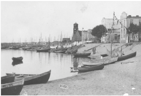
Fotografia 3. Minione krajobrazy „rybackiego Helu” – brzeg morski na odcinku portu rybackiego w Helu w latach 30. XX w. Źródło: fotografia ze zbiorów T. Muży
