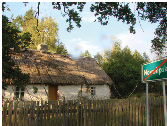
Fotografia 8. Nowolipsk – dom olęderski z darniowej rudy żelaza Źródło: W. Przewoźny (2010)
