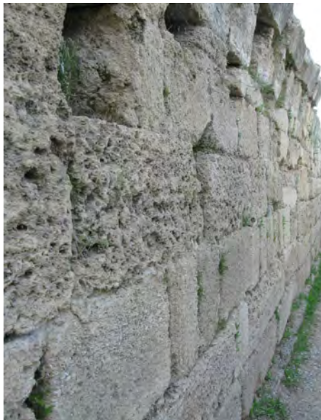
Ryc. 8.3. Powierzchnia muru wapiennego podlegająca wietrzeniu mrozowemu
