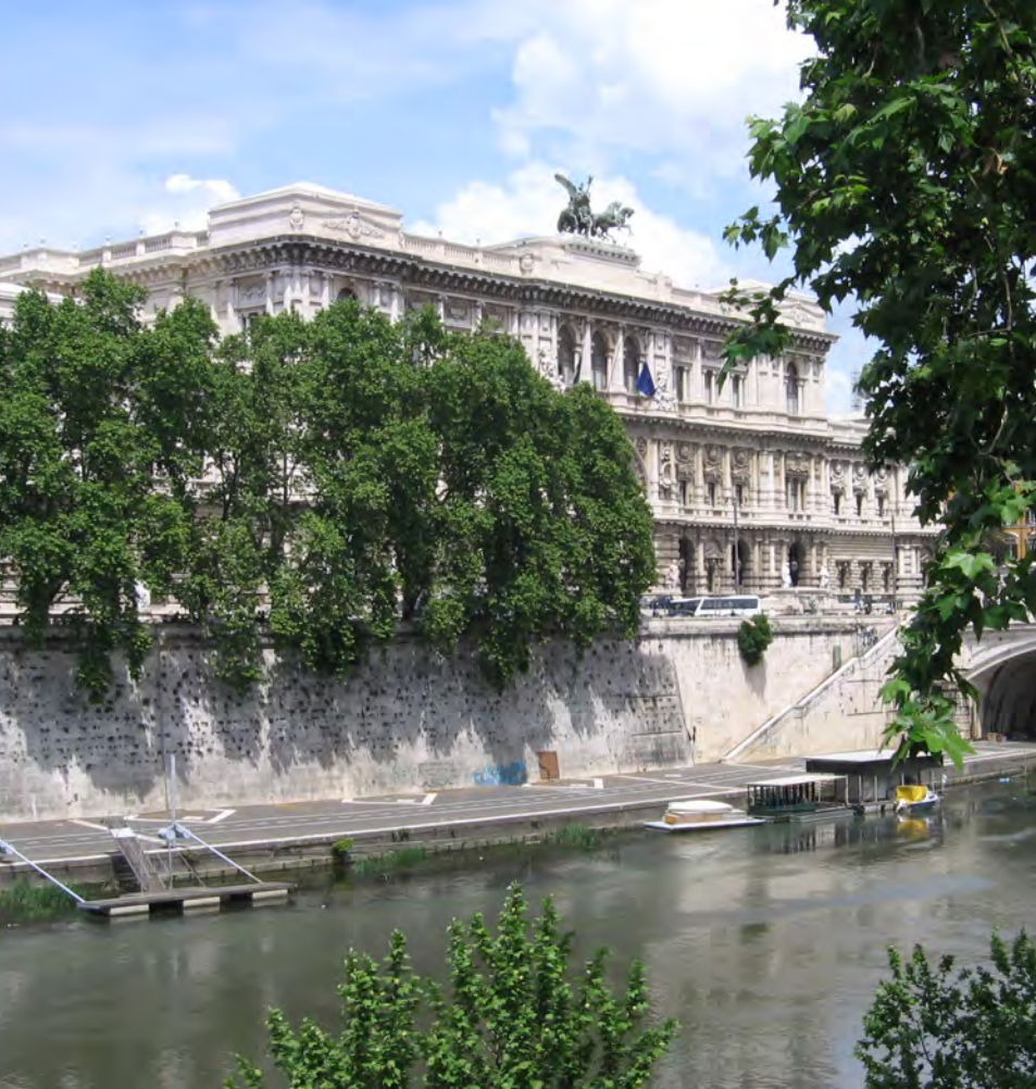
Ryc. 6.13. Dwupoziomowa obudowa koryta Tybru w Rzymie. Rzeka ujęta jest w kamienny kołnierz, który skutecznie zatrzymuje wody powodziowe i chroni zabytkową część miasta przed powodzią
