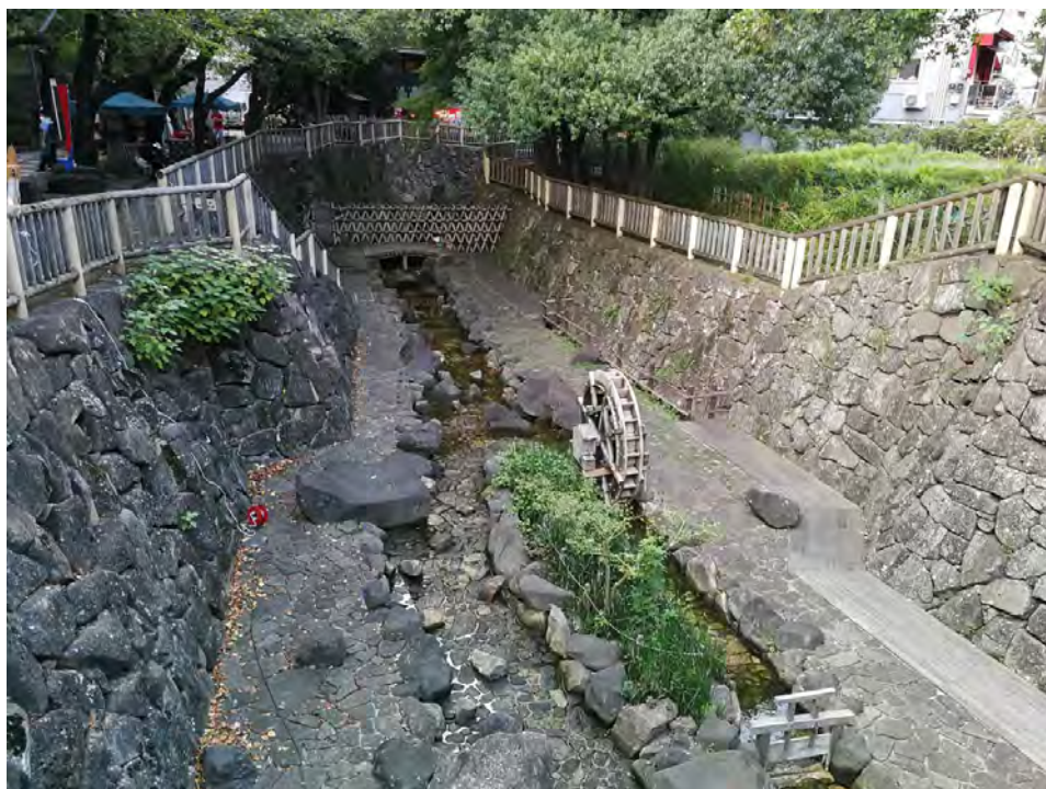
Ryc. 6.20. Mała rzeka w Tokio wykorzystywana jako kanał odpływu wód opadowych oraz miejsce spacerowe przy niskich stanach wody
