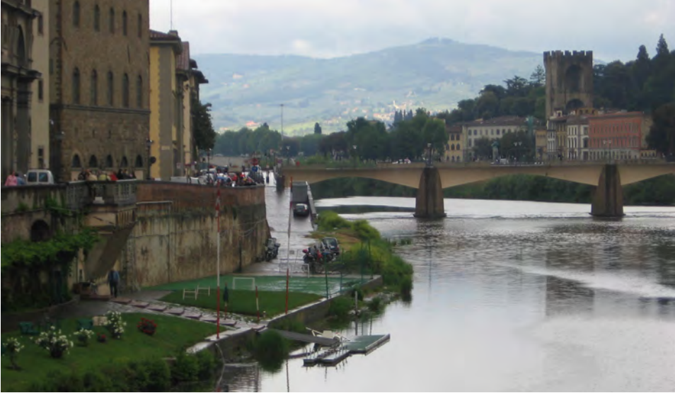
Ryc. 6.14. Przykład dwupoziomowej obudowy rzeki Arno we Florencji. Podczas niskiego i średniego stanu wody wyższy stopień nie jest zalewany, służy jako miejsce spacerowe, a nawet częściowo zajęty jest przez zieleń niską
