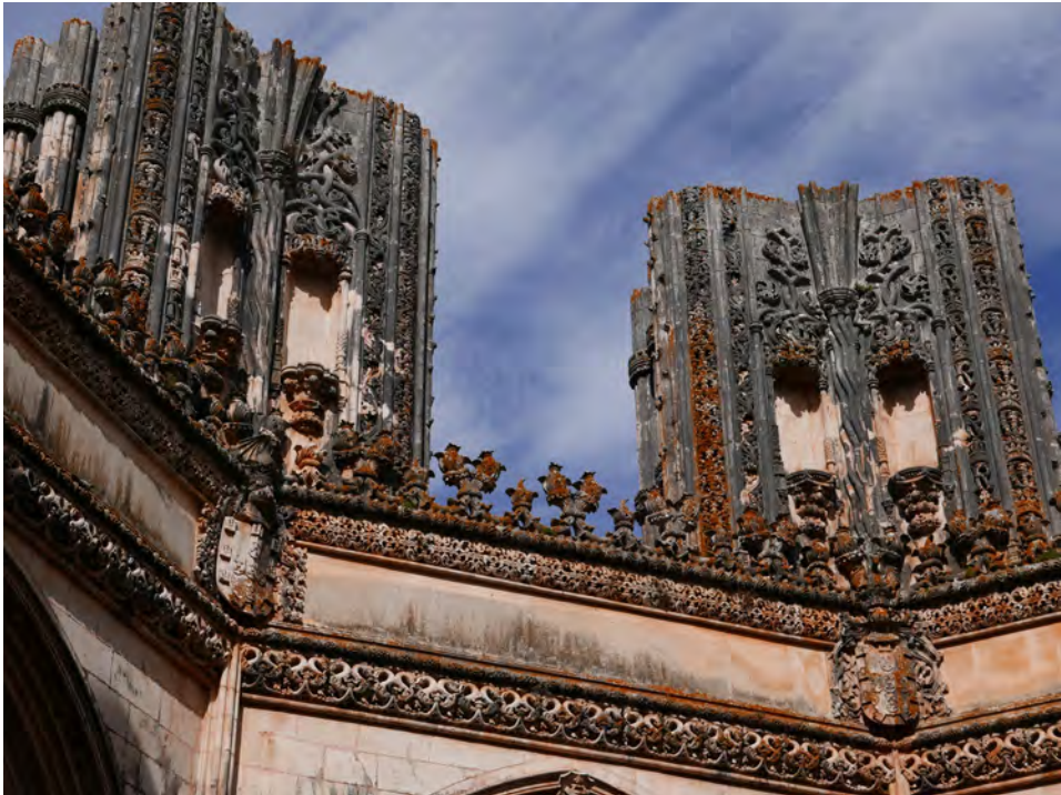
Ryc. 8.14. Czarny nalot na piaskowcu jako efekt złożonego wietrzenia chemicznego i biologicznego wzmoczonego zanieczyszczeniem powietrza, który niszczy kamień i obniża walory estetyczne, przykład z Portugalii
