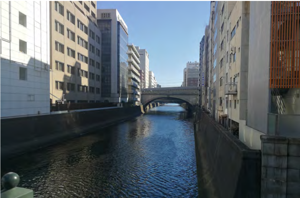
Ryc. 6.11. Przykład zabudowy zlokalizowanej bezpośrednio przy jednopoziomowej obudowie koryta w Tokio
