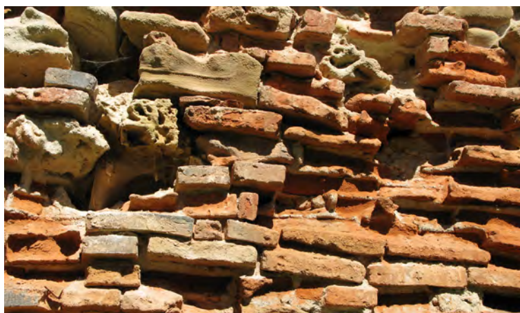
Ryc. 8.7. Wysypujące się wapienne spoiwo powodujące rozluźnienie wątku ceglanego. Silne wiatry i opady deszczu skutecznie usuwają wszelkie odspojone fragmenty
