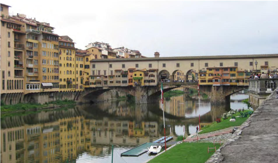
Ryc. 6.15. Ściany kamienne odpowiednio wyprofilowane i zabezpieczone tworzą mury dla koryta wysokiej wody, Florencja
