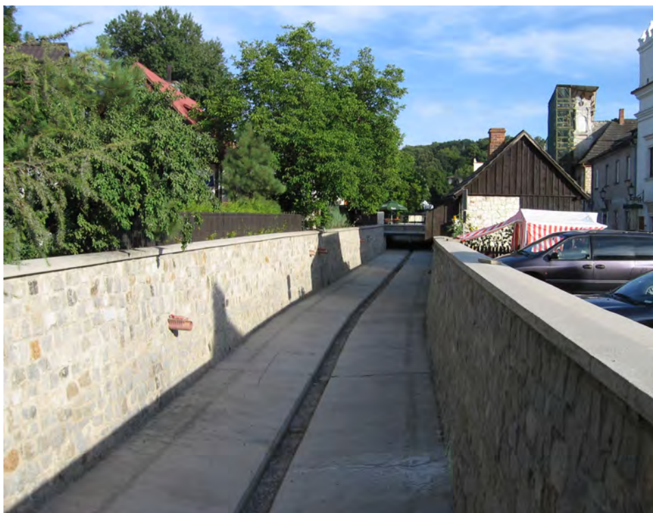
Ryc. 6.18. Przykład umocnionego koryta małej rzeki w centrum małego miasta
