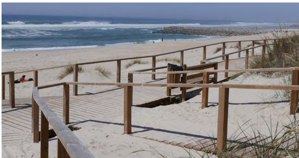
Ryc. 4.23. Drewniane kładki wybudowane na wydmach chronią rozwijające się trawy, które sprzyjają stabilizacji piasku
