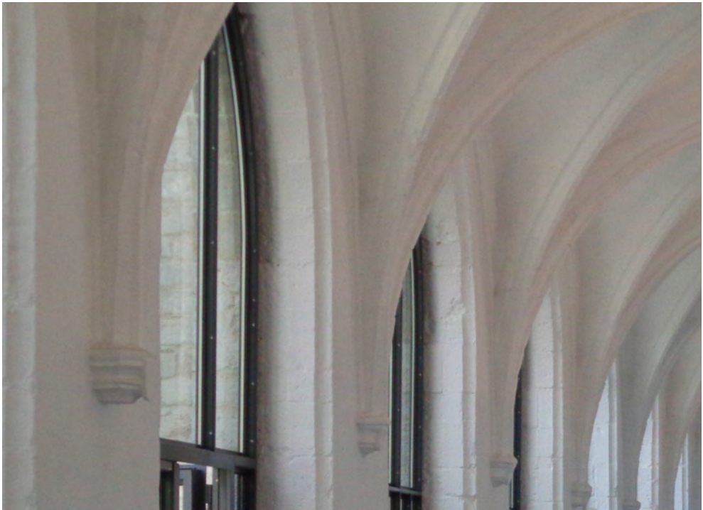
Fot. 9–10. Adaptacja szesnastowiecznego klasztoru na bibliotekę dla Katholieke Universiteit Leuven w Belgii, projekt Rafael Moneo, realizacja 2000–2002 (fot. Julia Sowińska-Heim)
