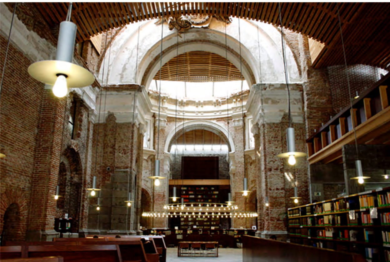
Fot. 36. Kościół Escuelas Pías de San Fernando zaadaptowany na centrum kulturalne i bibliotekę uniwersytecką, projekt José Ignacio Linazasoro, realizacja 2001–2004, Lavapiés–Madryt
