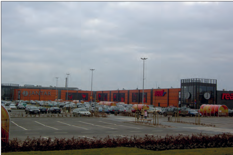
Fot. 2. Teren po byłym Zakładzie Sprzętu Okrętowego „Sezamor” przy ul. Szczecińskiej w 2015 r. (fot. I. Jazewicz)
