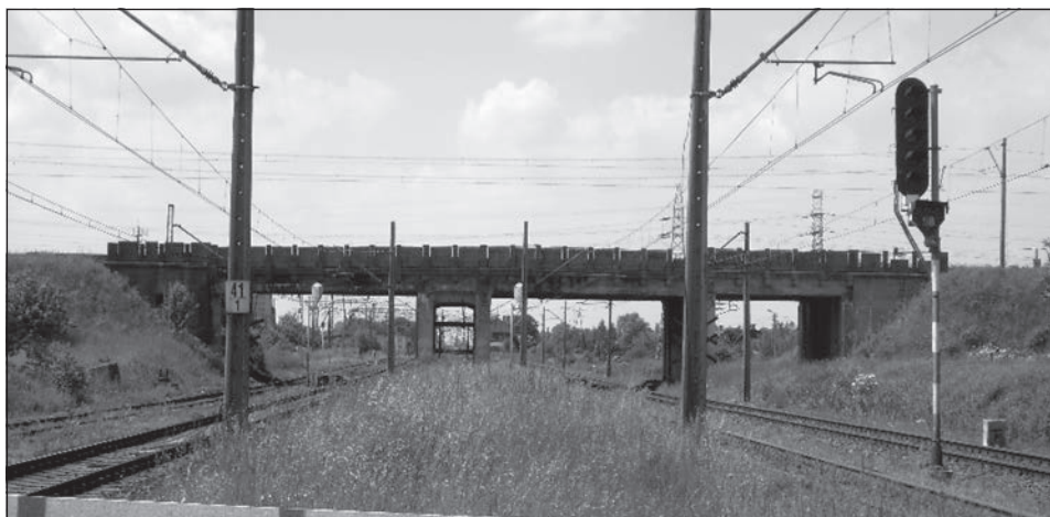
Rysunek 16. Wiadukt łączący linie kolejowe nr 14 i 131 (fot. Anita Kącka)
