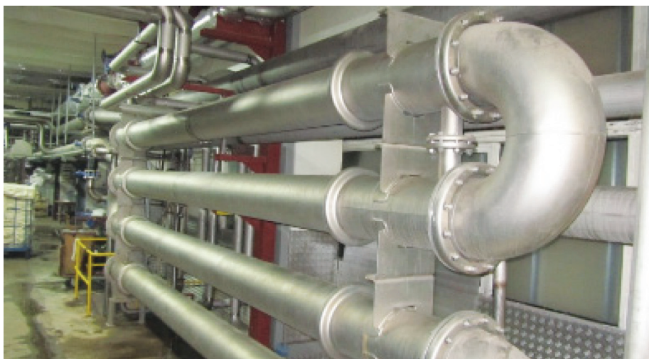
Fot. 5. Wymiennik ciepła typu rura w rurze firmy Dofama Thies Sp. z o.o.
